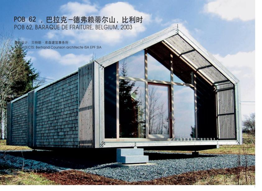
POB 62 是一个基于原型的设计,以最简化的方式建造。"模块建筑"(以 1.25 m × 6.25m 为模数)的构建特征使它具有很好的灵活性,可以在不破坏整体外观协调性的条件下满足任意新增加的空间使用需求。
